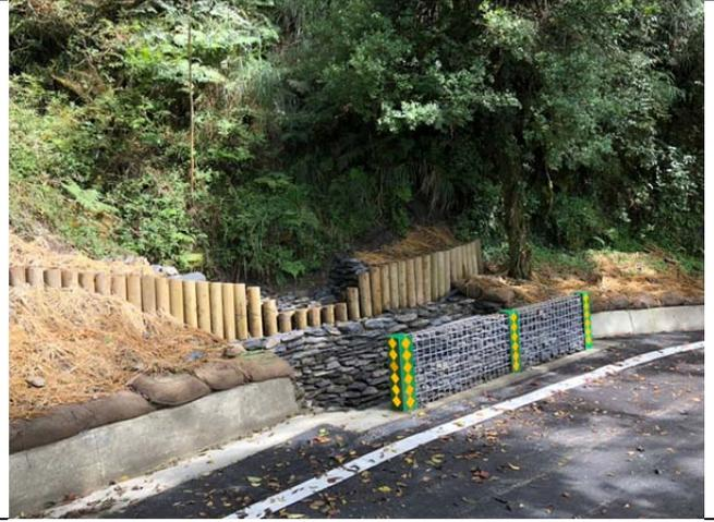
木排樁導流工及砌石靜水池完工情形
