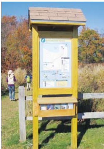
圖10 解說牌下側放置相關解說摺頁，為防下雨淋濕，摺頁架上方均另設有防水遮板。
