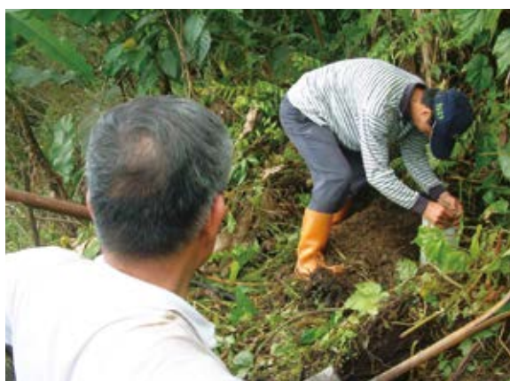
▲ 現場檢訂人員埋測衛星控制點樁
