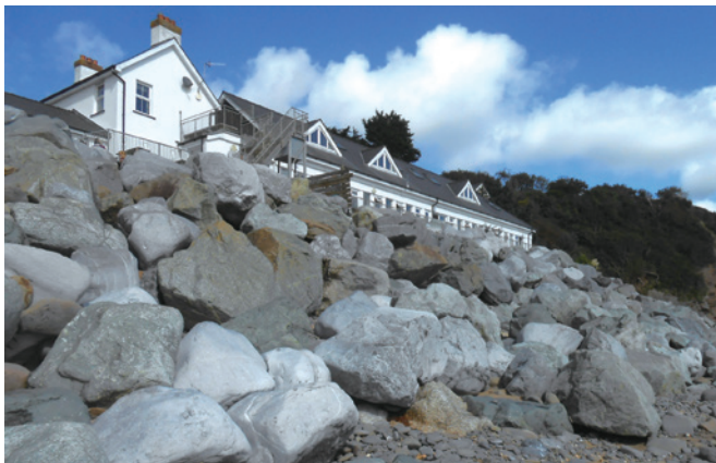
引導學生練習Hudson's equation，及藉由測量防波石塊的大小、材質來估算重量，評估其現有海岸防禦的成效如何。
