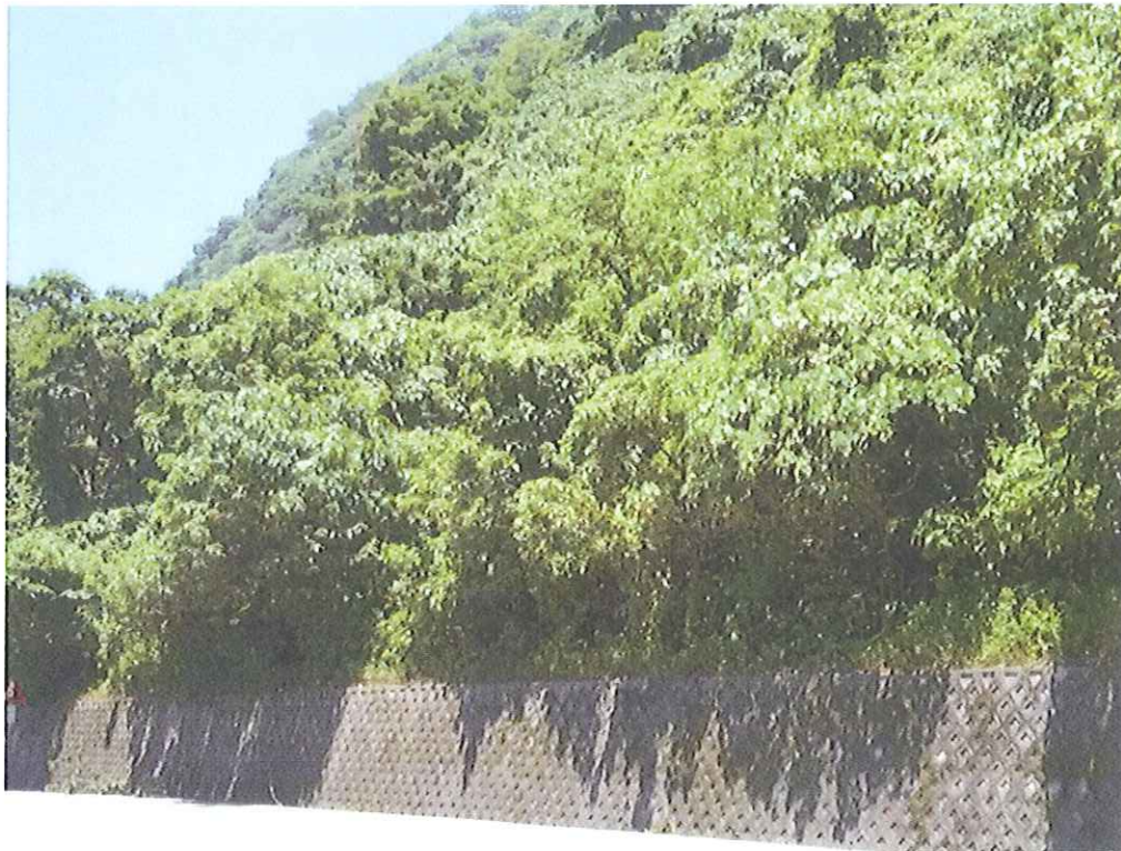
邊坡解除區域
