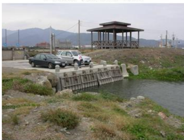
四重溪口西岸有閘門與涼亭
