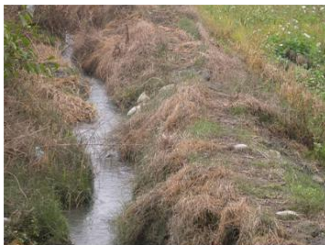
大安溪省道1河床渠道
