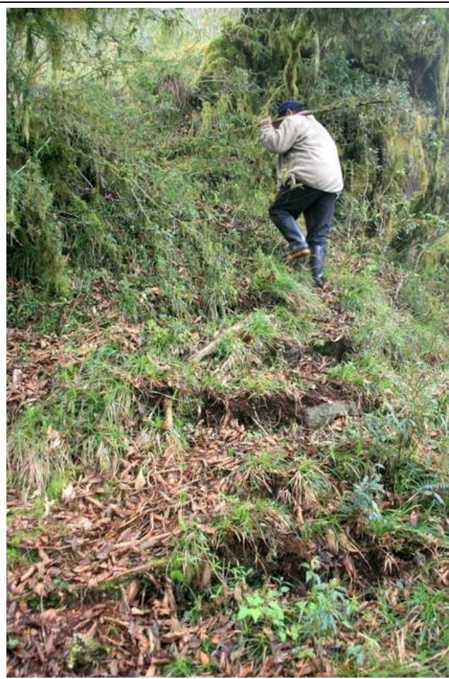
山勢更為陡峭處古道便採「之字型」上升，而此處石階的寬度、規模皆較小，也比較容易遭自然力毀壞（石階 3）
