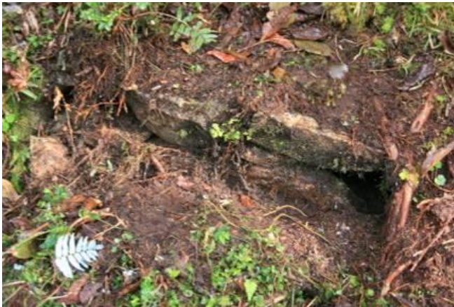
同一處石階群會使用不同的石材，左圖石階是用大小相似但厚度扁平的石版堆砌而成，右圖石階則是由一整塊石材修砌而成，較左圖石階穩固、耐用、不易毀損。（石階 1）
