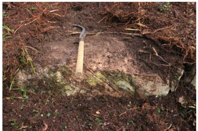
同一處石階群會使用不同的石材，左圖石階是用大小相似但厚度扁平的石版堆砌而成，右圖石階則是由一整塊石材修砌而成，較左圖石階穩固、耐用、不易毀損。（石階 1）
