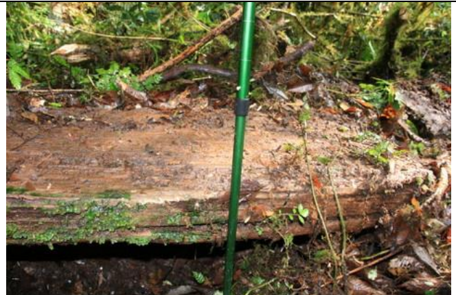
木板側面，木料仍無腐朽毀壞情況
