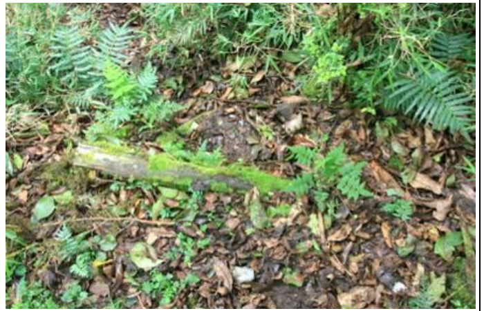
由木階上方往下坡方向拍攝，可見木階固定泥土後形成照片下方的踩踏面（木階 1）
