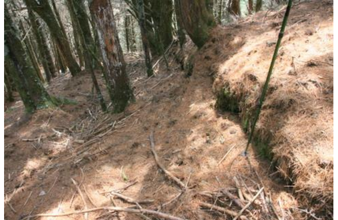
山勢平緩處，邊坡開挖規模也會比較少，如照片所示此處邊坡高度僅約 40 公分（坡道 4）
