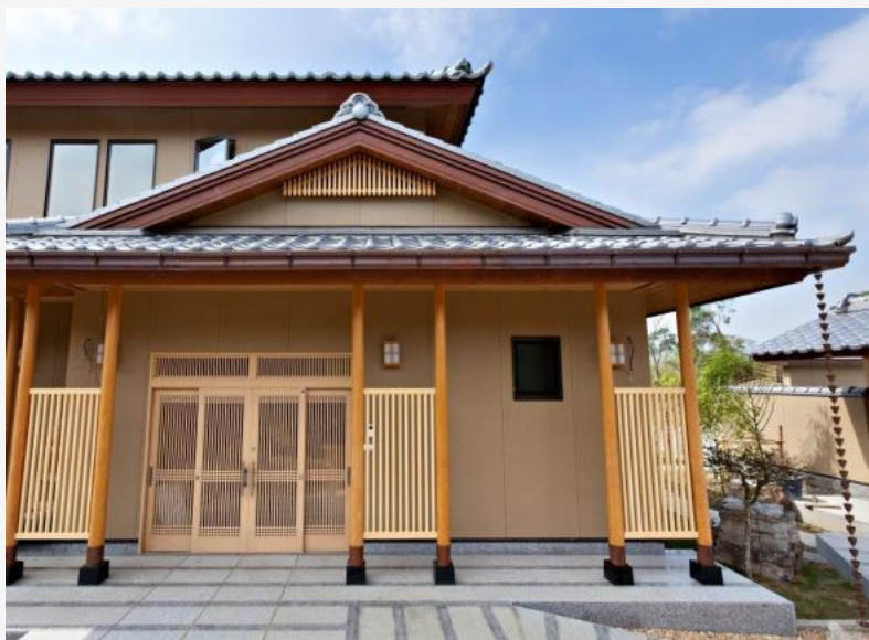
照片 8. 木構造建築 ( 日式樑柱工法 ) ( 鈴木健康綠營造股份有限公司 )
