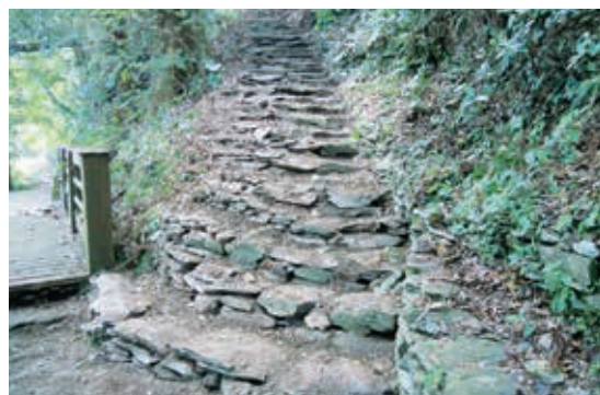
▲ 以部落傳統工法鋪設的砌石步道
