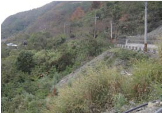
▲奧萬大聯外道路6.9K週邊地滑整治工程改善前情形
