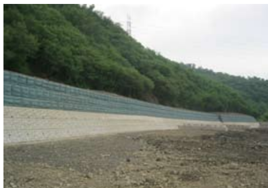
▲屏東處—潮州38林班災後復建二期工程
