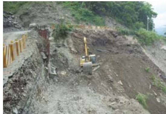
▲藤枝林道13K周邊災害復建工程改善前情形
