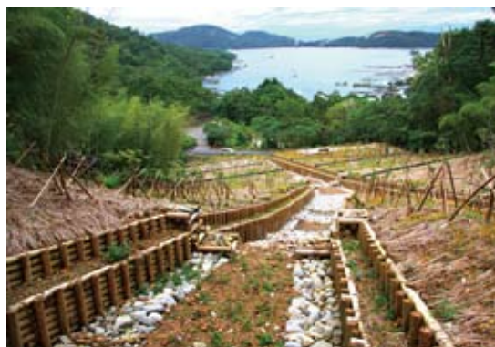
▲南投處—日月潭巒大區29林班坡面處理及坑內坑溝處理工程
