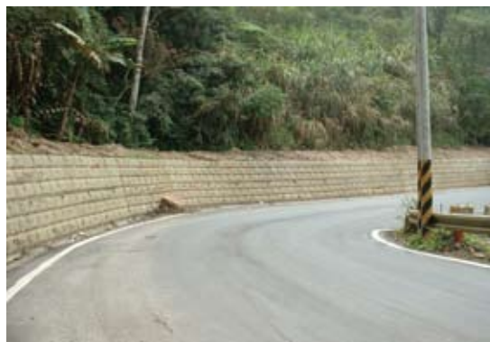
▲大鹿林道1K道路整治工程改善後情形
