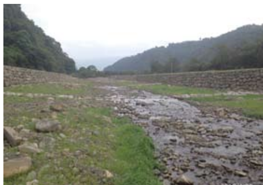
▲羅東處－頂粗坑溪護岸及堤防整建工程
