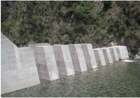
▲東勢處－匹亞桑溪第一期整治工程
