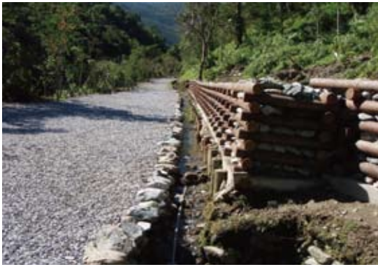
▲花蓮處－白鮑溪設施維護工程
