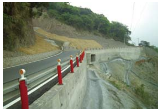
▲藤枝林道13K周邊災害復建工程改善後情形
