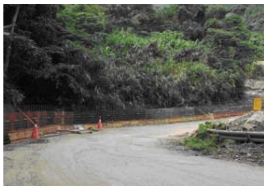
▲大鹿林道1K道路整治工程改善前情形
