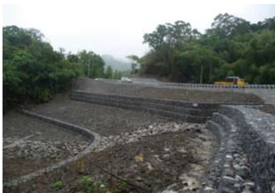
▲臺東處—松林崩場地整治二期工程
