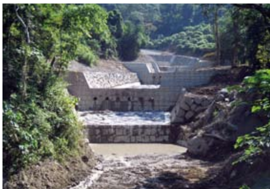
▲嘉義處－大埔區第81林班崩場地整治工程（二）
