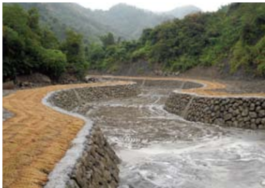
▲嘉義處－玉井區67林班大牛林坑野溪整治工程
