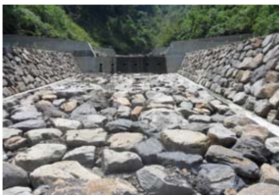
▲新竹處－石門水庫庫區崩場地復育2期工程
