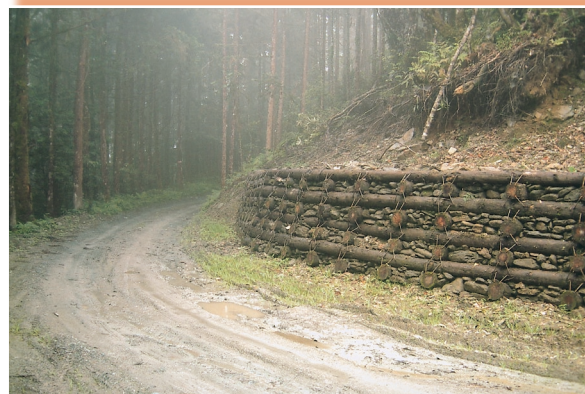
瑞穗林道木格框穩定邊坡之情形 謝宏松／攝
