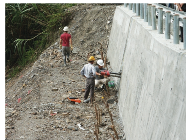
本局工程督導羅東處現場混凝土鑽心取樣
