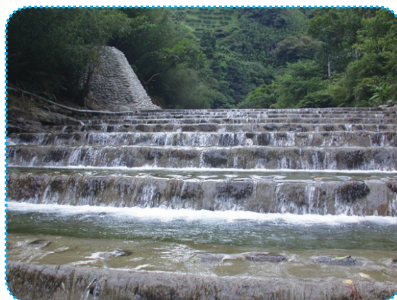
蚋仔溪第二號潛壩魚道增建工程（施工後）—新竹處 吳子健／攝
