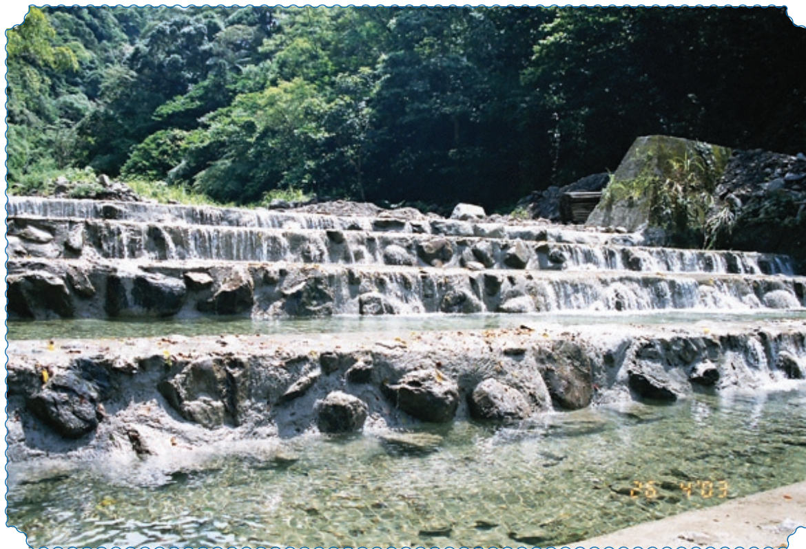
熊空溪防砂壩加強工程 新竹處 陳炳煌／攝
