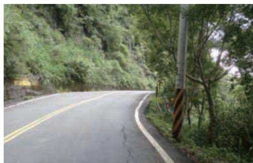
▲南投處－奧萬大 4K+500 聯外道路地層滑動、路面龜裂，路基工程改善前情形
