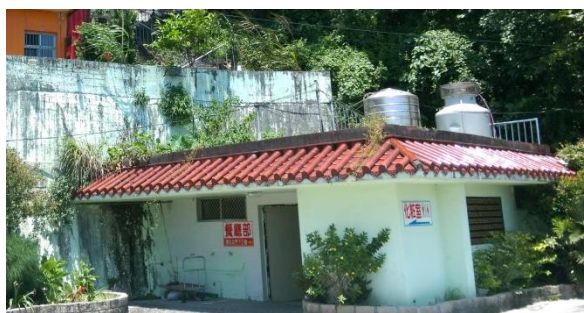
2277 地號之內現況_建地 鎮安宮房舍(解除建物部分)
