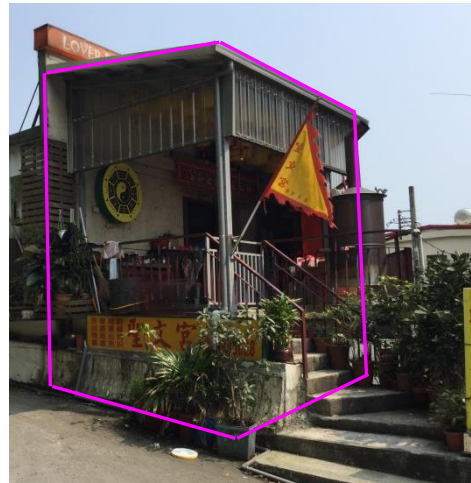
2278、2278-3 地號之內現況_建地 (蘇澳鎮內埤路 100 號旁建物後方)
