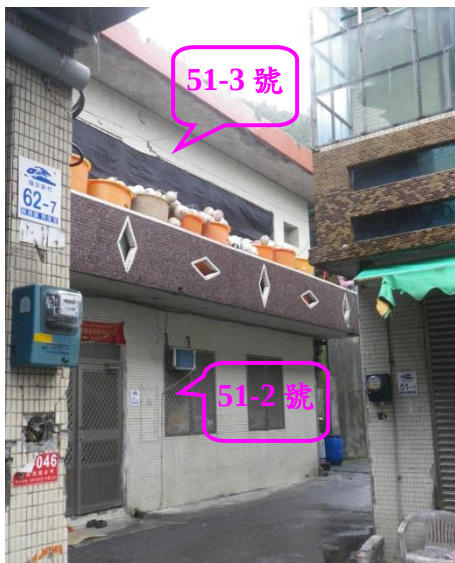
2244-2、2244-3 地號之內現況 建地【建物 A】 (福安新村51-2、51-3號 為同一棟建物，解除建物全棟) (註:51-2號為51-3號下方樓層)
