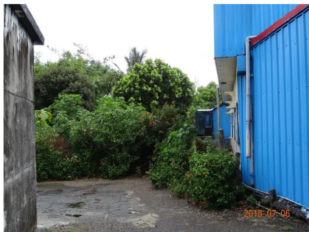
現場照片 註：圖號 83、107 解除後所形成之畸零地
