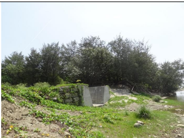
排水溝右側(擬編入九棚段 713 地號西南側)
