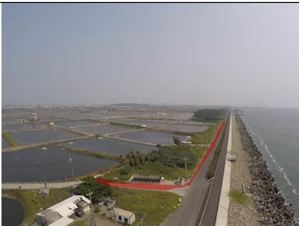
港口段 514、523、551、556、557 之內地號空拍照
