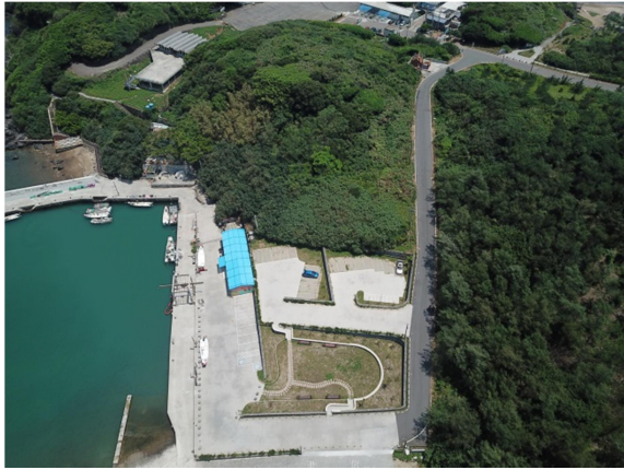
現況照片O-海巡檢查哨、停車場及漁港
