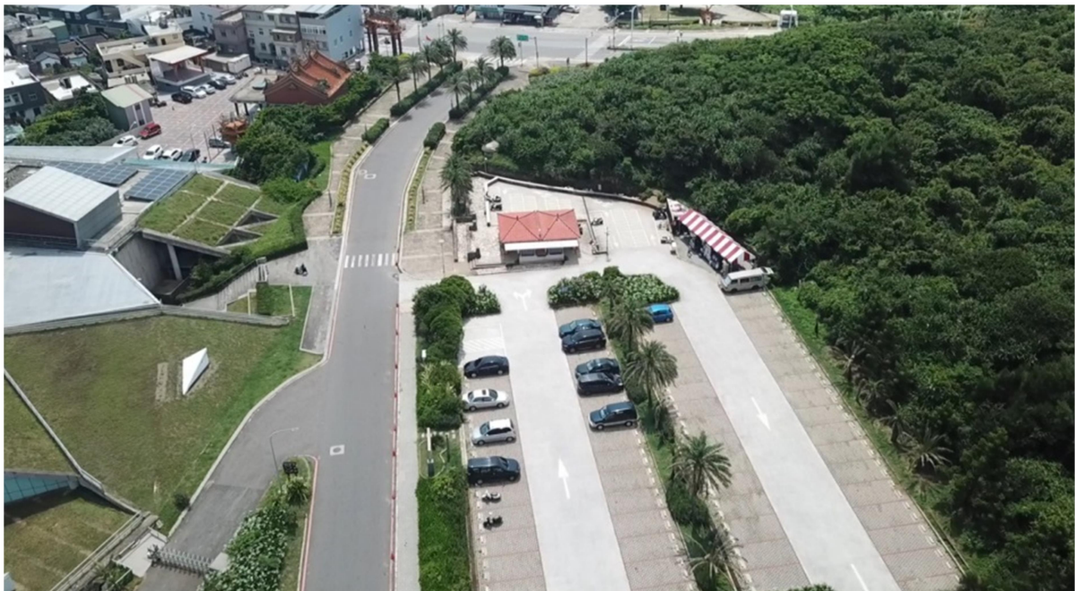
現況照片 Q (9-67、9-69 之內地號)
