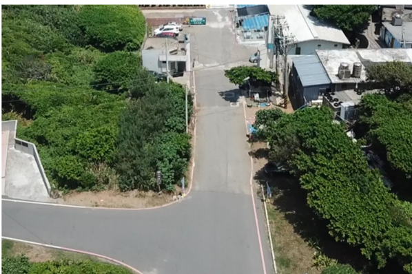
現況照片P-道路
