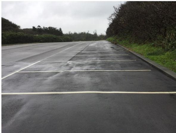
現況照片 O-第二停車場
