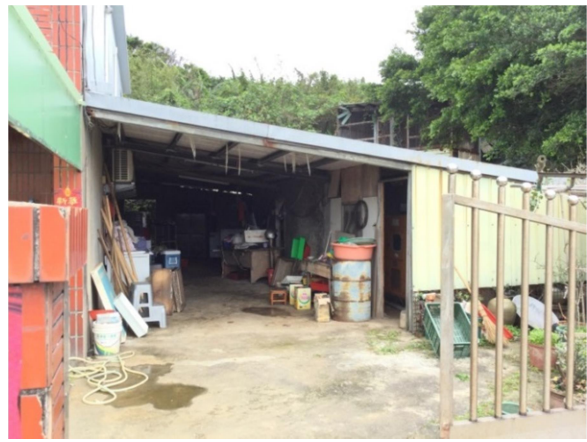
位置 F 現況照片(建物)
