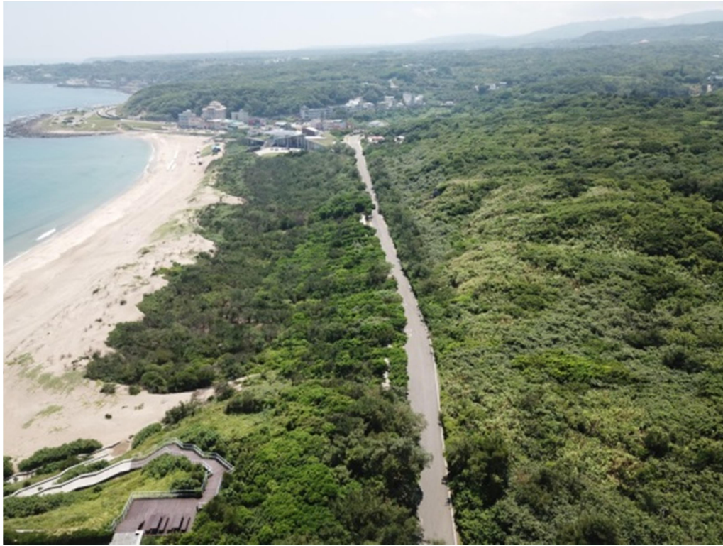
現況照片 Q (9-47、9-56 之內地號)
