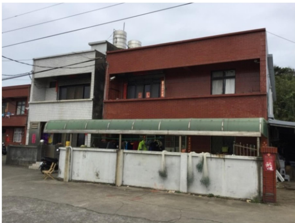
位置 F 現況照片(建物)
