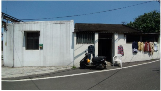
現況照片J-1(105-68之內地號)建物及畸零地
