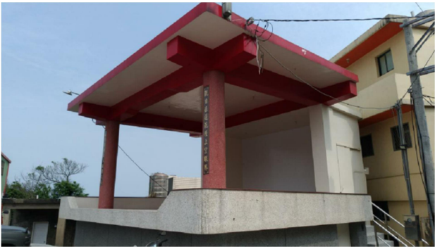
現況照片R-1戲台
