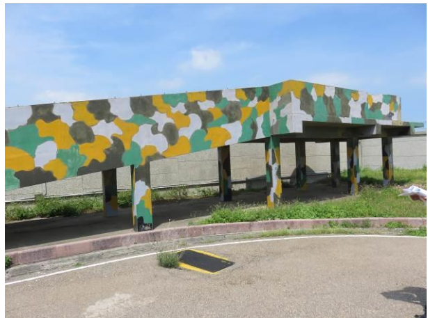
287、289、298、299 地號現場照片
