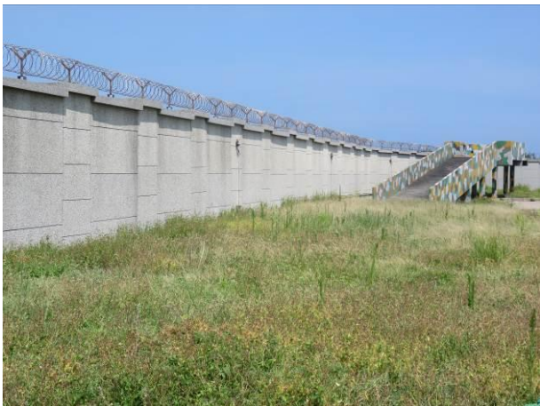
287、289、298、299 地號現場照片
