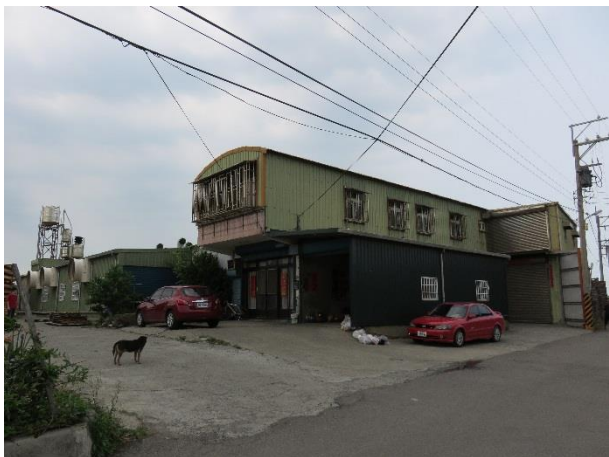
496 地號現場照片
