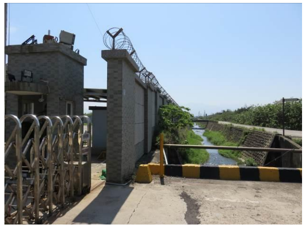
147、274 地號現場照片
