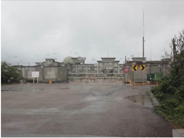
275、277、280、301 地號現場照片
