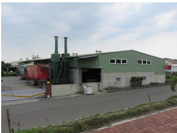
497、500 地號現場照片
