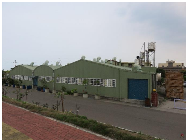
496 地號現場照片
