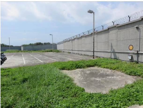
147、274 地號現場照片
