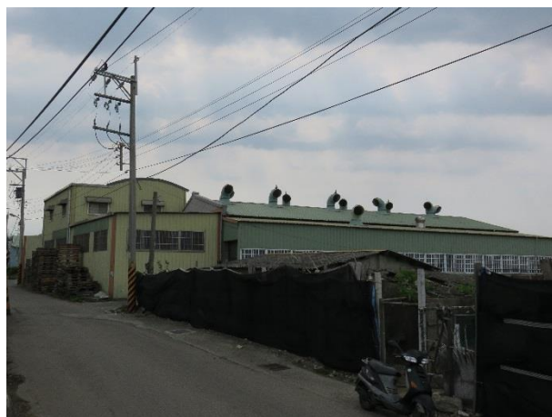
497、500 地號現場照片
