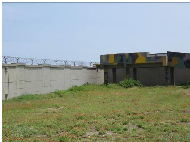
17、264 地號現場照片
