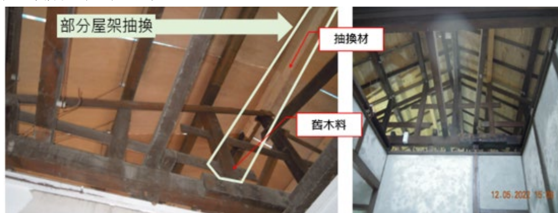
圖 2 竹東林場舊建築使用漂流木抽換木構架
