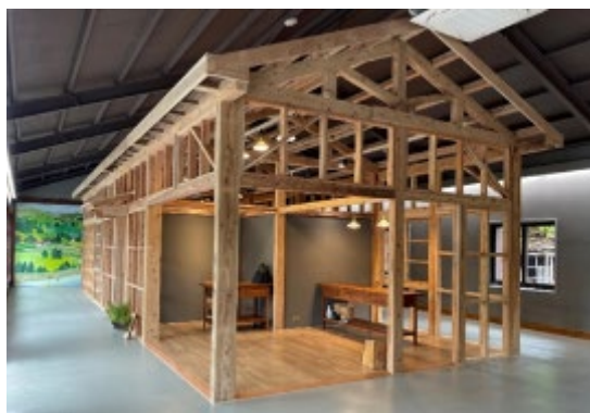
圖 6 運用國產材修復卡車修理庫
