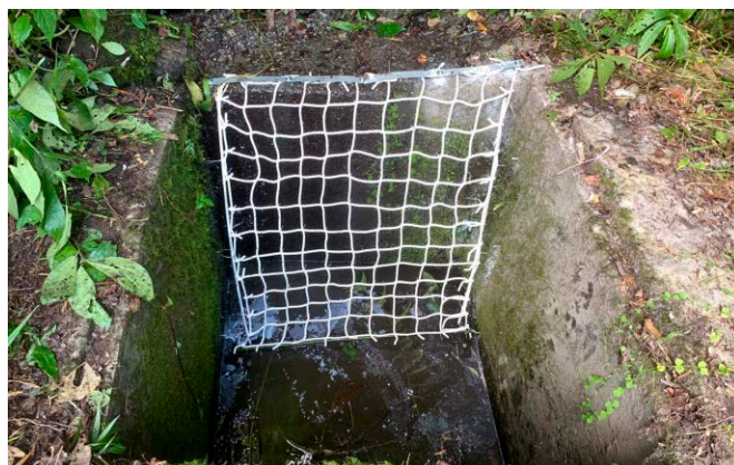
▲ 中平林道集水井設置棉繩網，協助掉落井底動物攀爬出井
