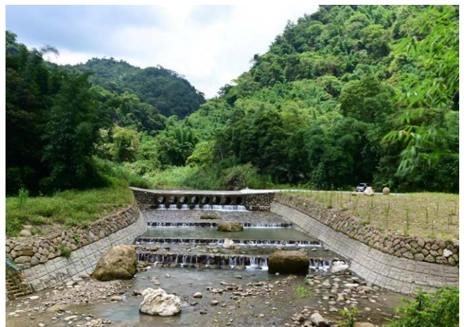
▲ 大埔區第 55 林班防砂整治工程
