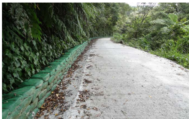
▲ 西林林道改善工程
