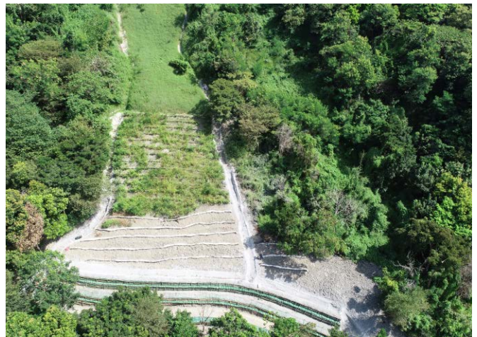
▲ 花蓮處－豐濱鄉浴海段崩塌地處理工程
