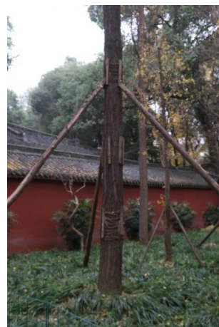
照片 33：支撐用之木桿亦以鐵釘固定
