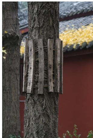
照片 32：保護樹幹之木條以鐵釘固定
