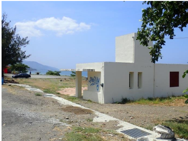
現場照片(廁所)
