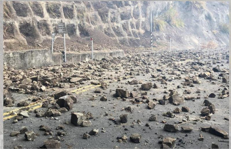
坡面因火焰高溫(至少700度以上)膨脹，崩解產生落石
