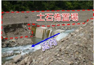
採開挖深槽土砂溪岸安置，土砂仍會進入到庫區
