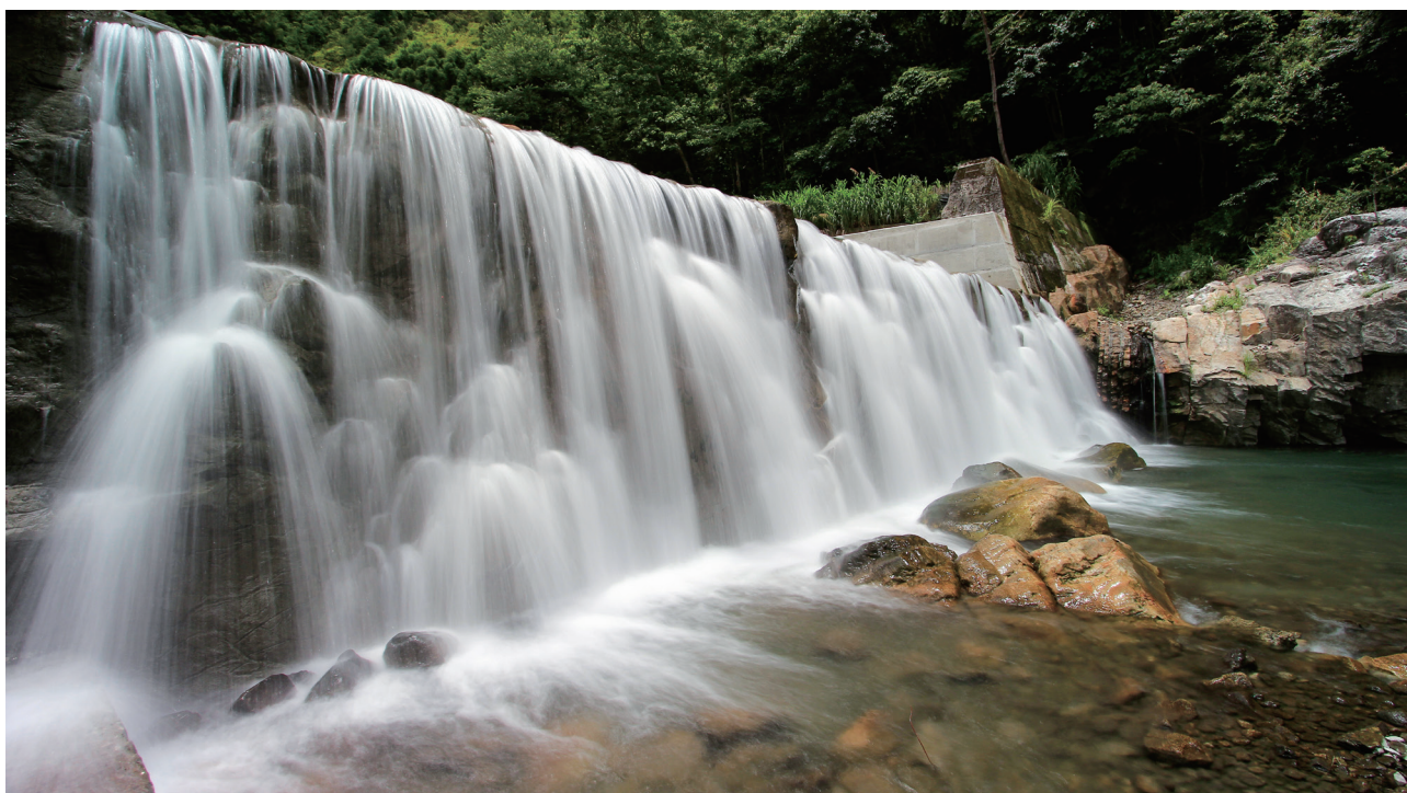
裡冷溪防砂壩改善工程
