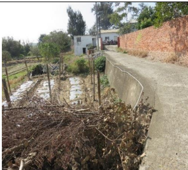
現場相片:道路、壑地
