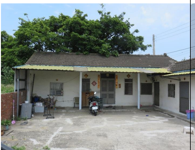
D 建物現場相片：
