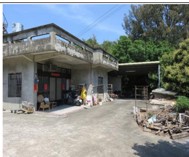
D 建物現場相片：
