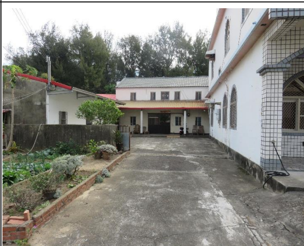
D 建物現場相片：
