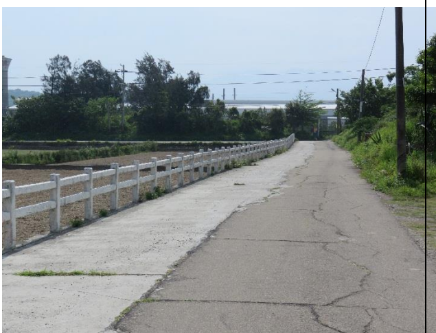
現場相片：道路
