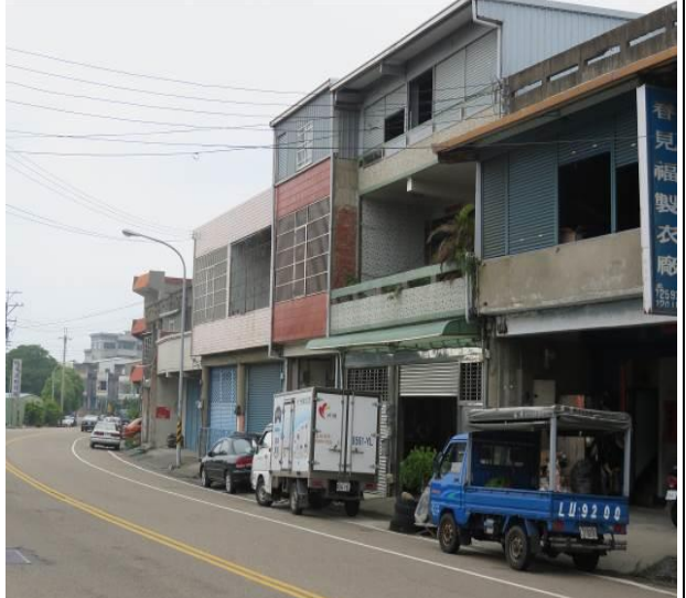
C 建物現場相片：
