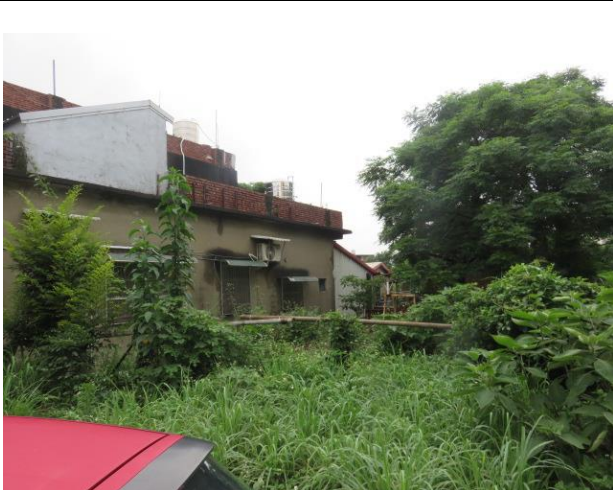
G 建物現場相片：
