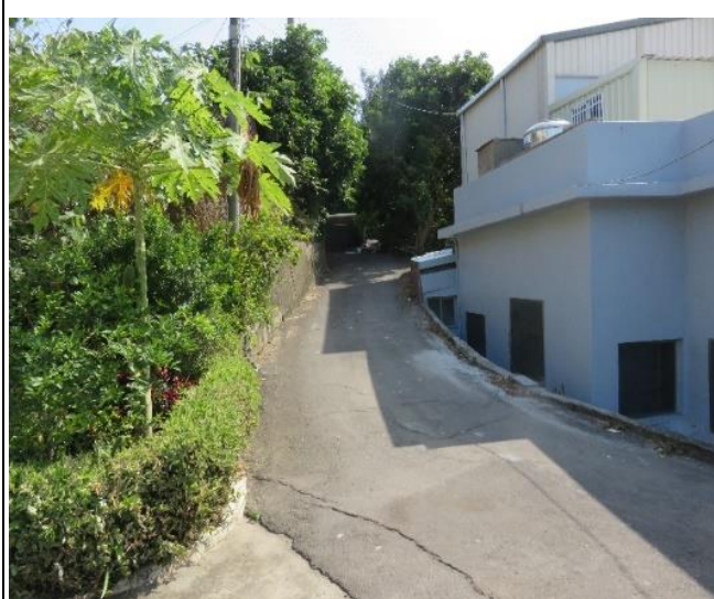
現場相片:道路
