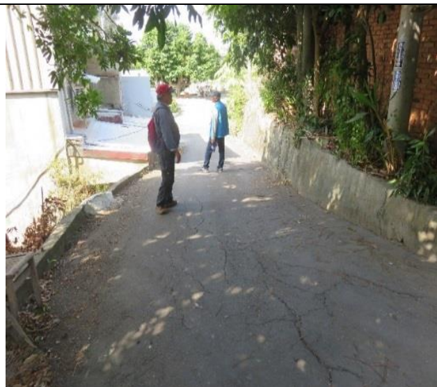
現場相片:道路
