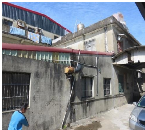
B 建物現場相片：
