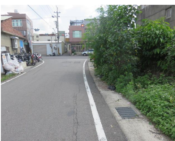
現場相片：道路
