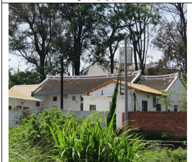
G 建物現場相片：
