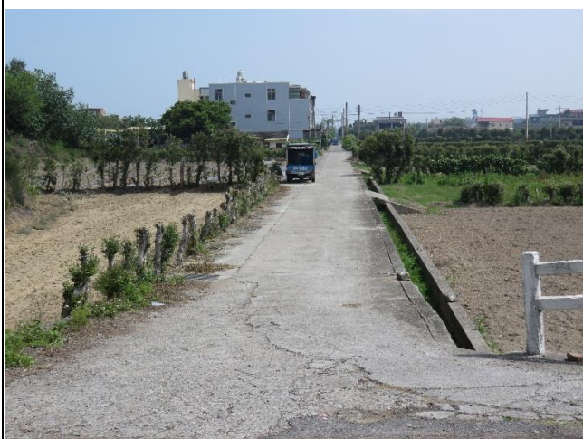
現場相片：道路
