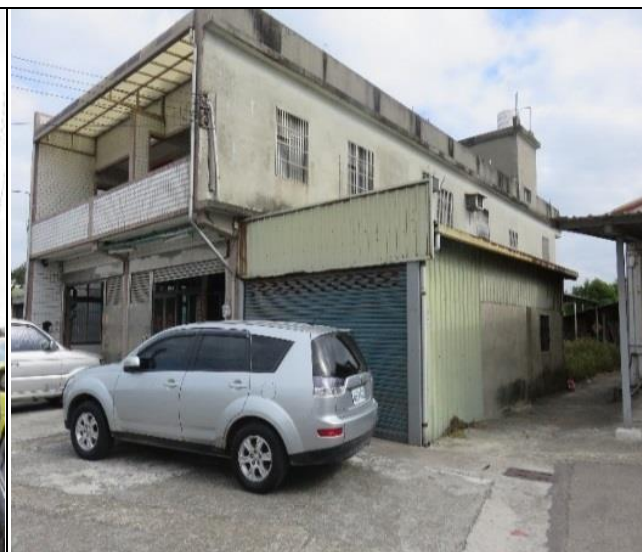
B 建物現場相片：
