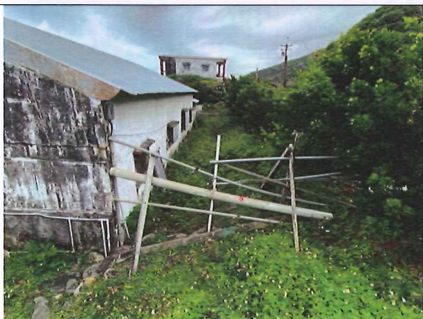
編號(E)現場照片(九棚段 737 之內地號)
