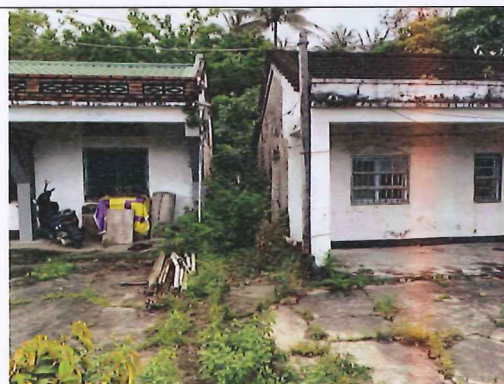
編號(F)現場照片(响林段 1101 之內、1100 之內地號)
