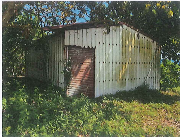
編號W 現場照片(响林段 1122 之內、1123 之內、地號)
