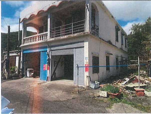
編號 H 現場照片(响林段 1103 之內地號)
