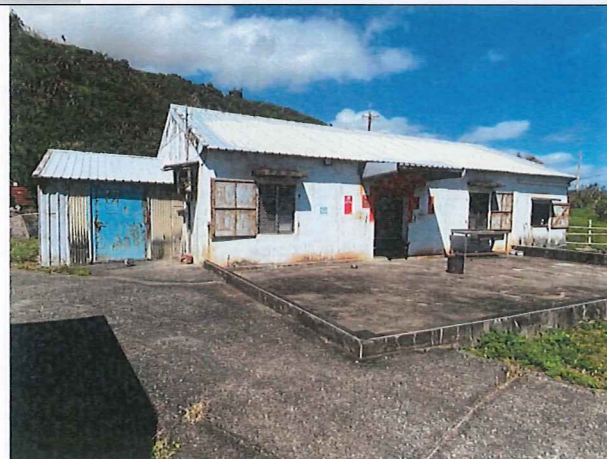
編號E 現場照片(九棚段 737 之內地號)
