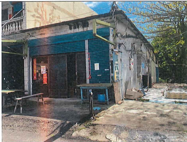
編號 J 現場照片(响林段 1108 之內、1109 之內、1113 之內地號)
