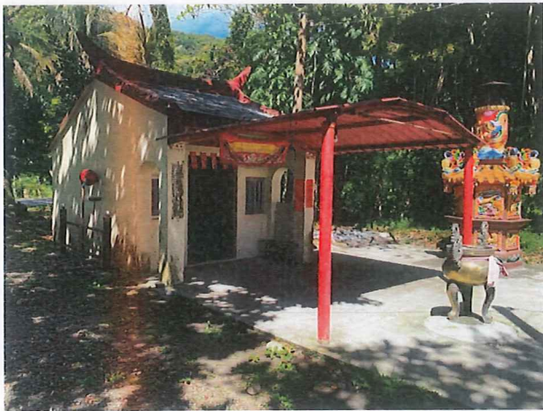
編號X 現場照片(响林段 1114 之內、1129 之內、1130 之內、1131 之內地號)
