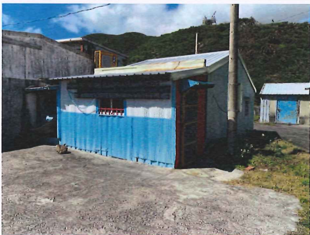
編號F 現場照片(九棚段 739 之內、739-1 地號)
