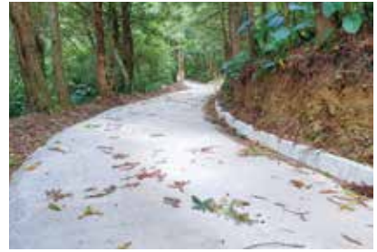
▲ 水田林道支線路面及排水改善工程
