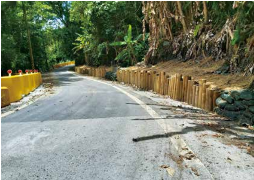
▲ 中平林道0k - 15k改善工程
