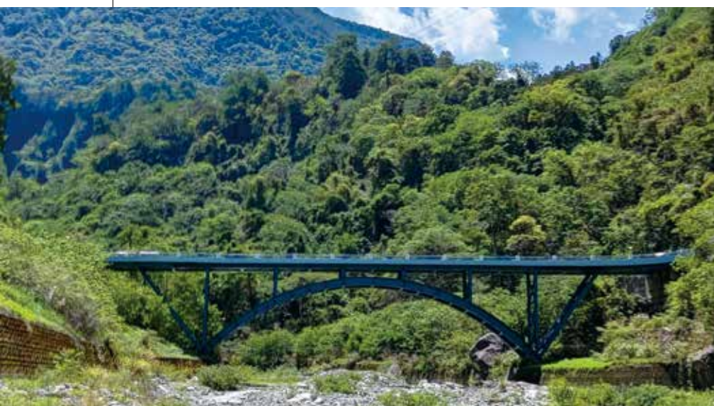
▲ 仙文橋塗裝及沿線改善工程
