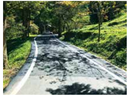
▲ 祝山林道主支線邊坡路面排水改善工程
