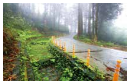
▲ 雙龍林道沿線道路改善工程
