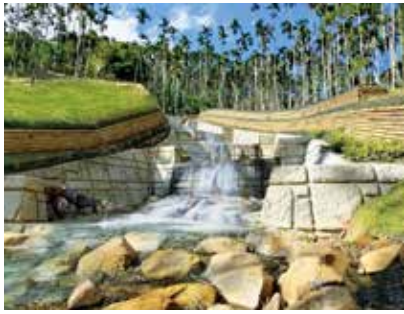
▲ 110年度巒大區5林班坑溝整治工程
