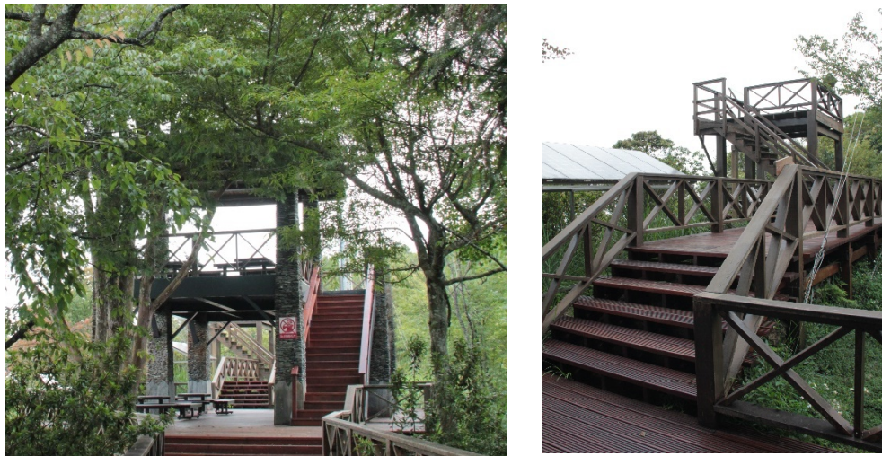
圖 4-16 瞭望台設施現況
