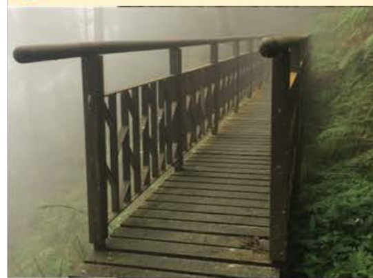
④ 鋼構棧橋
