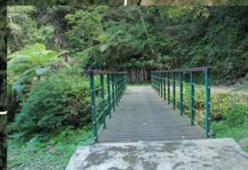
⑥ 鋼構扶手棧橋
