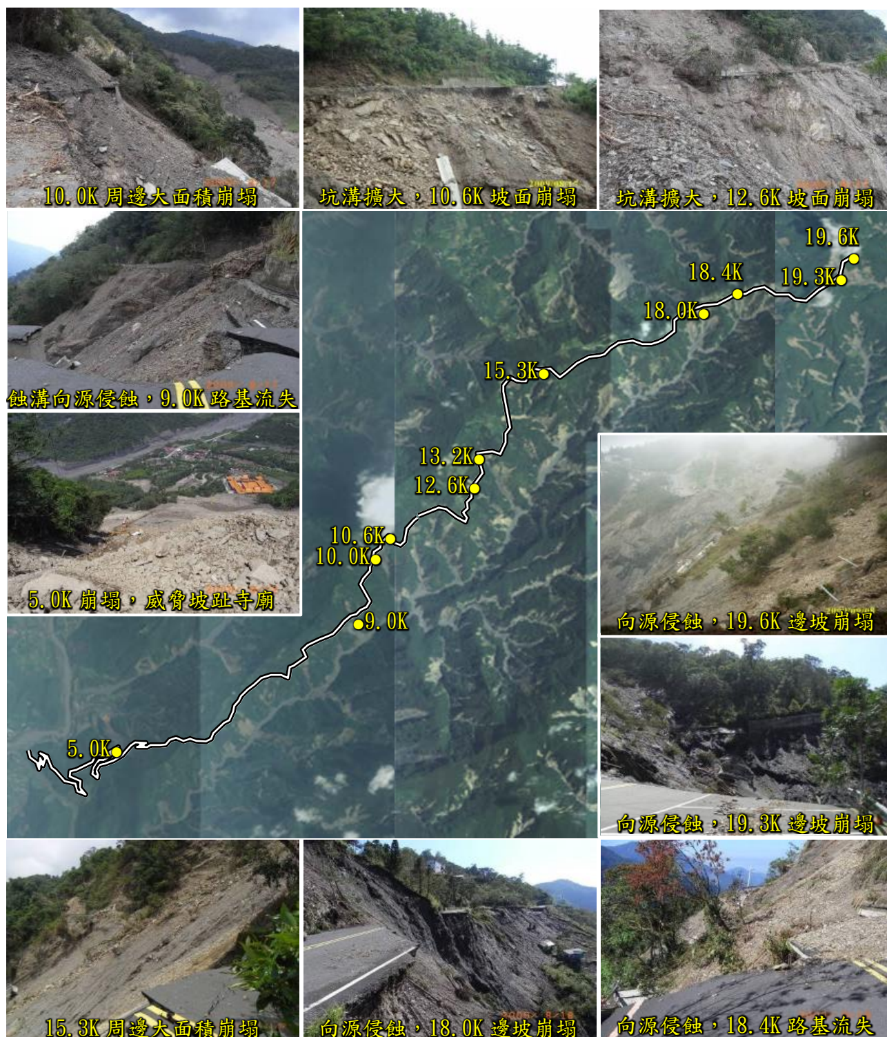
莫拉克風災後聯外道路沿線大型崩塌地災況照片
