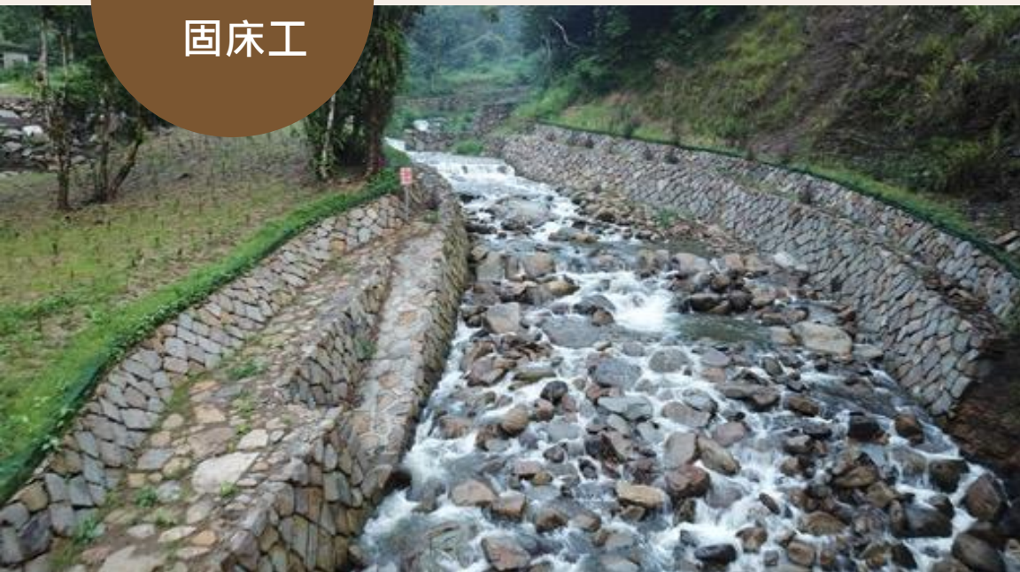
新店烏來平廣溪 防砂工程
