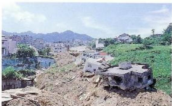
山坡地開挖成建地，由於管制不嚴，造成房屋傾斜，土壤流失
