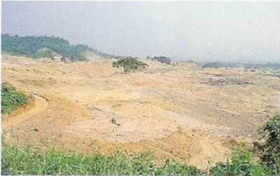
山坡地大量開挖往往將原有地形破壞易造成水土流失
