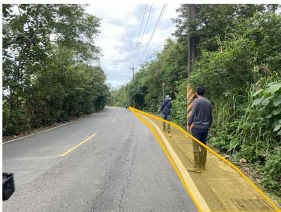
288 地號之內現況照片 道路(季水路)
