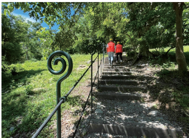
▲「知本森林遊樂區步道群設施改善二期工程」，通透性護欄保障使用者安全且提供動物穿越路徑。
