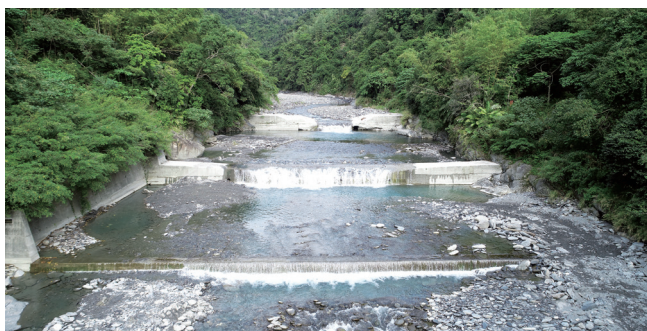
▲臺東林管處「利嘉溪流環境改善二期工程」，採壩體開口工法調整河溪縱向斷面緩坡化，營造有利於水中生物及動物之友善棲地。
