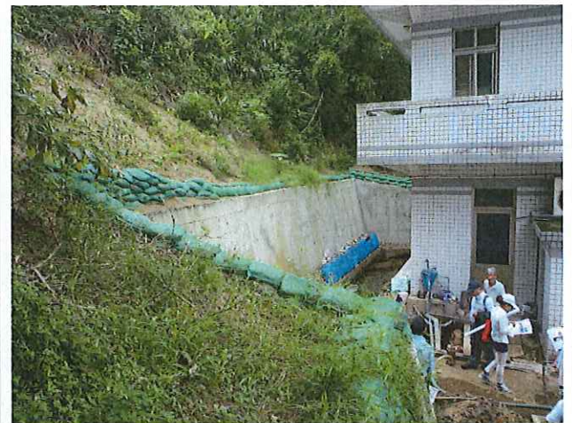
水土保持邊坡穩定設施~羅東處之治山工程
