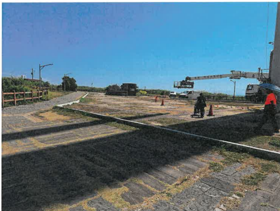
苗栗縣後龍鎮過港段643-153地號現場照片(空地)
