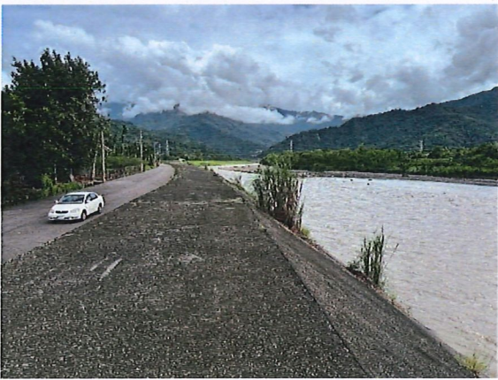
萬安溪北側堤防→ 往萬安溪上游拍攝 (堤防左側保安林現況)
