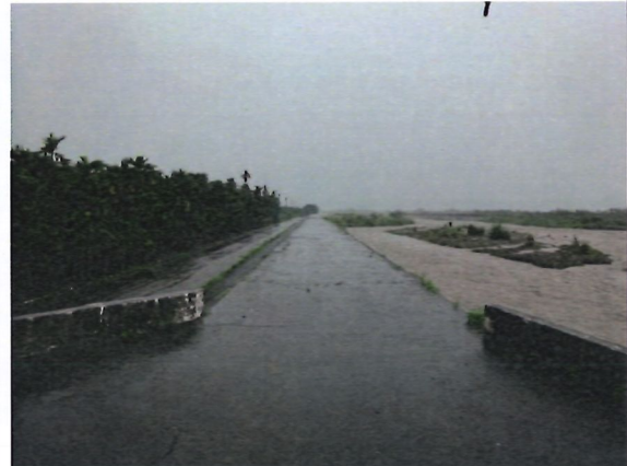
萬安溪北側堤防→ 往萬安溪上游拍攝 (堤防左側保安林現況)
