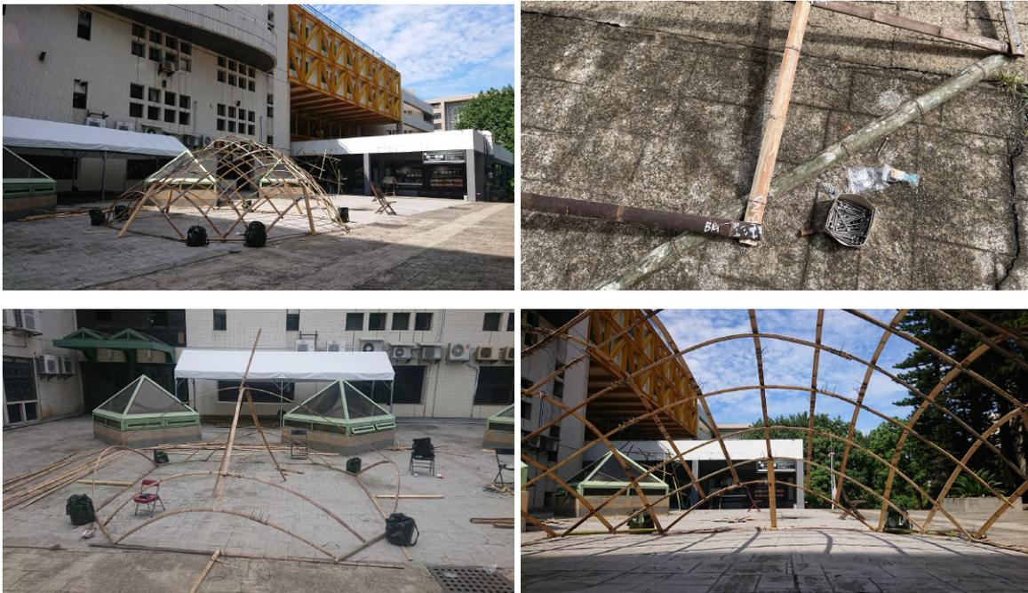
圖116：彈性網殼第二次實作建造過程
