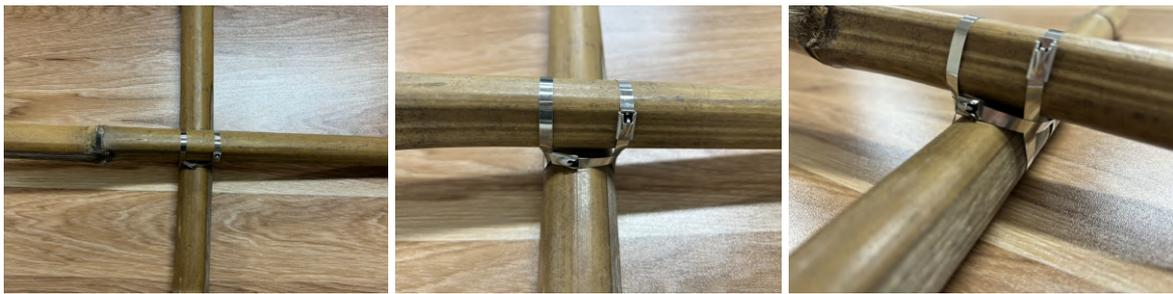
圖53：不鏽鋼束帶回字加固繞法
