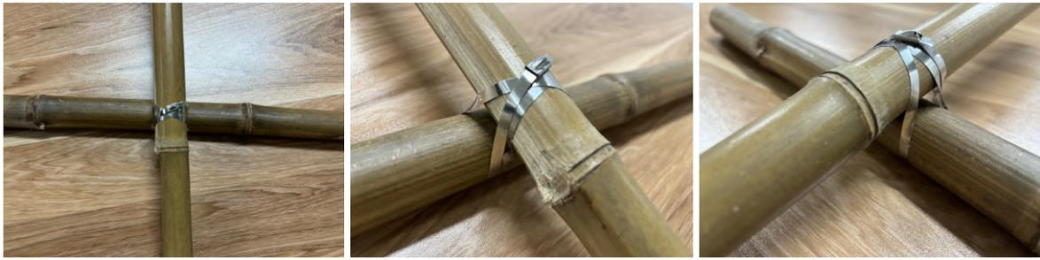
圖52：不鏽鋼束帶X型繞法
