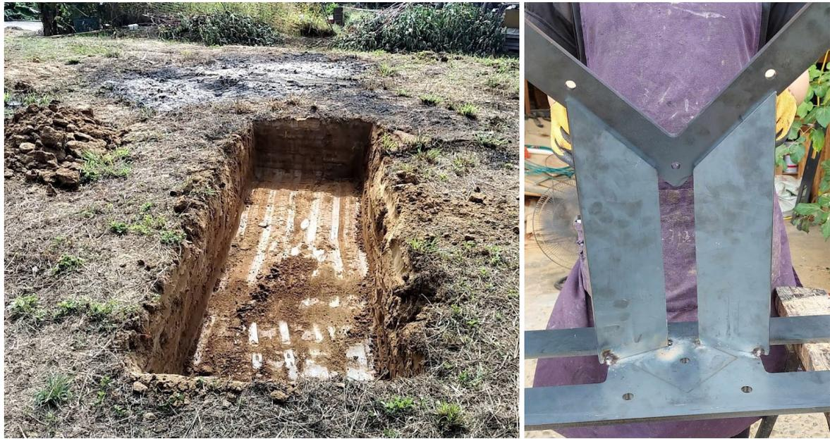
圖136：彈性網殼第四次實作基礎開挖與基座鐵件
