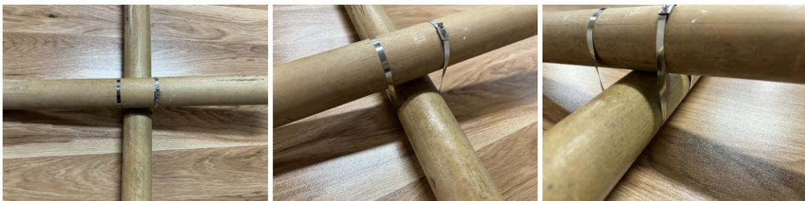
圖51：不鏽鋼束帶回字繞法
