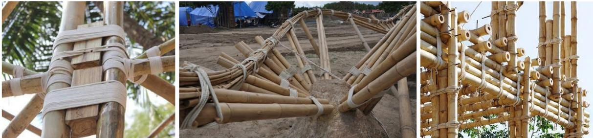
圖1：竹接頭傳統工法示意圖[14]
