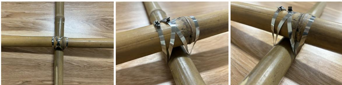
圖54：金屬束帶X型加固繞法
