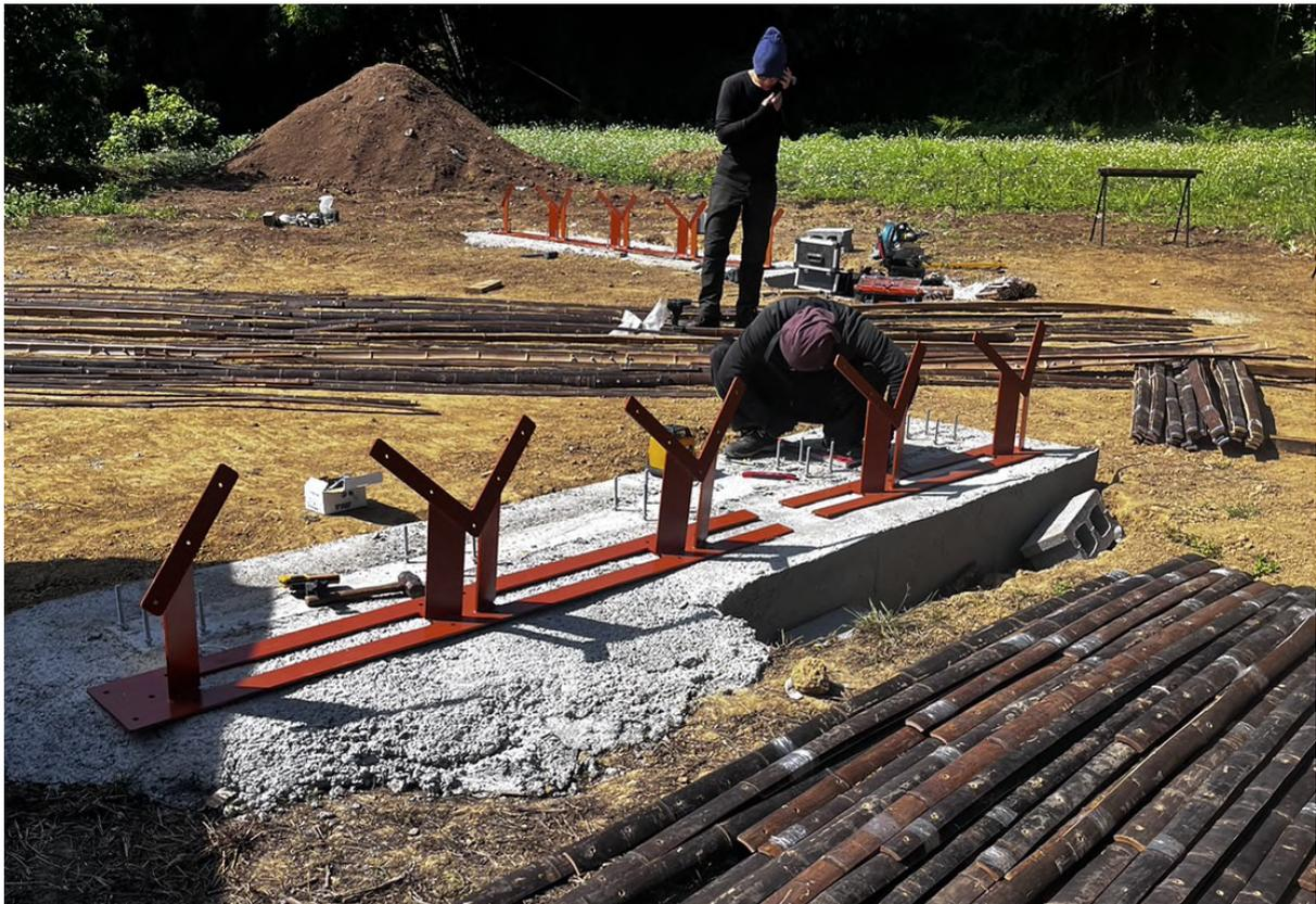
圖137：彈性網殼第四次實作基礎灌漿與基座鐵件固定
