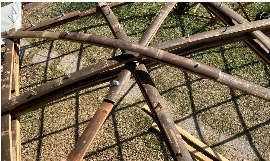
圖125：彈性網殼第三次實作補強之細部形變狀況
