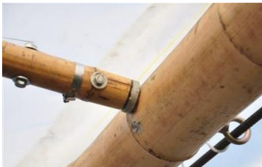
圖 8.7 以鐵件圍束之竹構接合[22]
