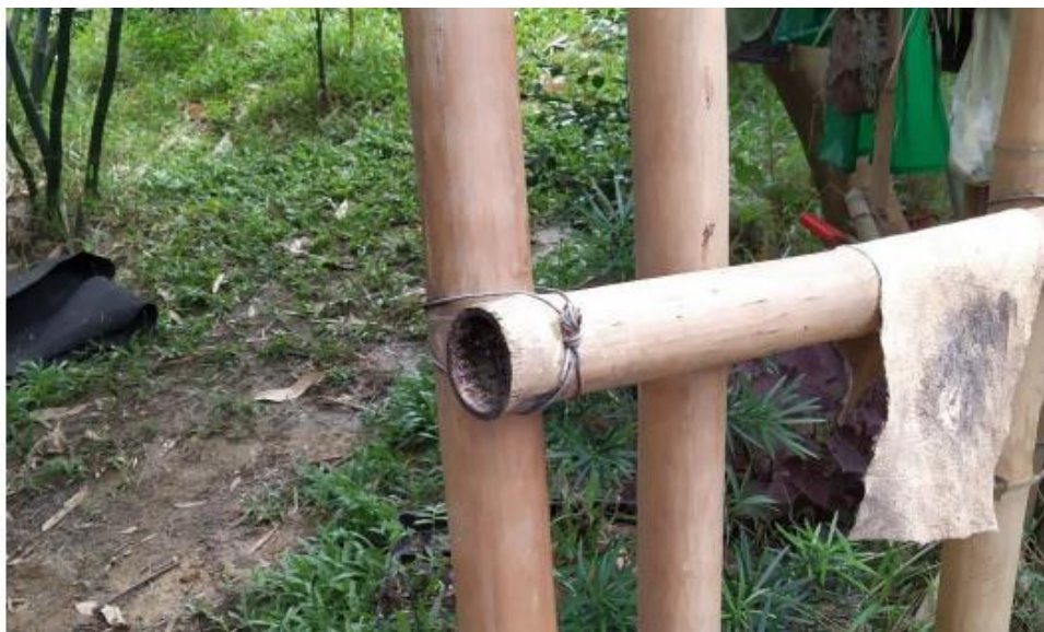
圖 8.10 以鐵線綁紮之正交橫接[22]
