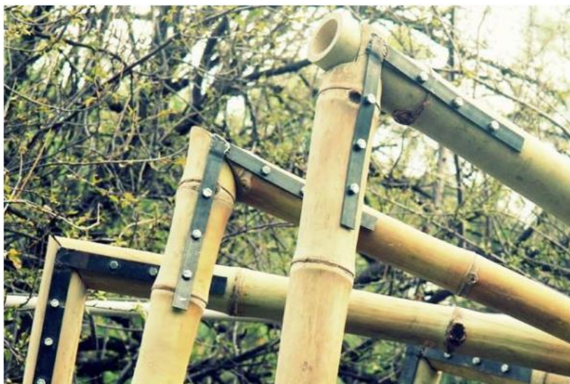
圖 8.12 以金屬側板接合的共平面接合[21]
