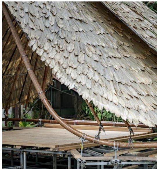
圖 8.15 小支竹完全連續的膠合形成新的接合關係
