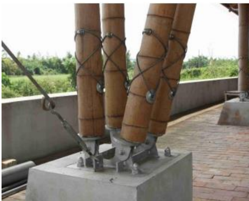
圖 8.11 大藏聯合建築師事務所設計之支承端接合[22]
