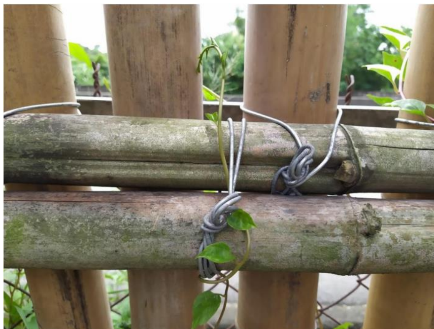
圖 8.3 以鐵線綁紮接合之竹構造[22]
