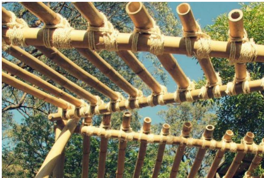
圖 8.2 以麻繩綁紮接合之竹構造[21]
