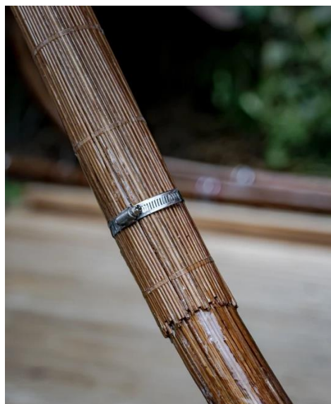
圖 8.14 以小支竹構成的連續接合方式
