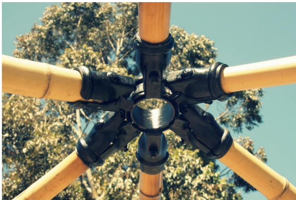
圖 8.4 連接外包式夾具之金屬多向接合[21]
