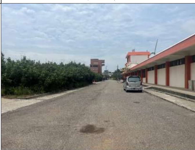
桃園市觀音區白沙屯段下庄子小段216-1、 235-3地號現況照片
