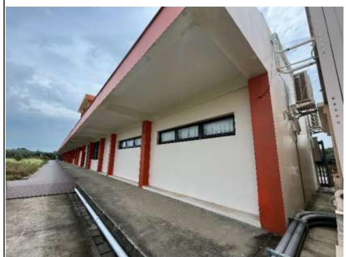
桃園市觀音區白沙屯段下庄子小段216-2地號 現況照片
