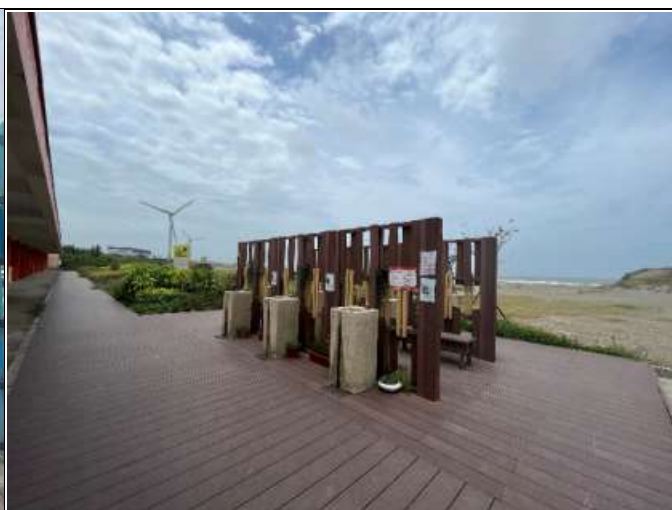
桃園市觀音區白沙屯段下庄子小段215-1地號 現況照片
