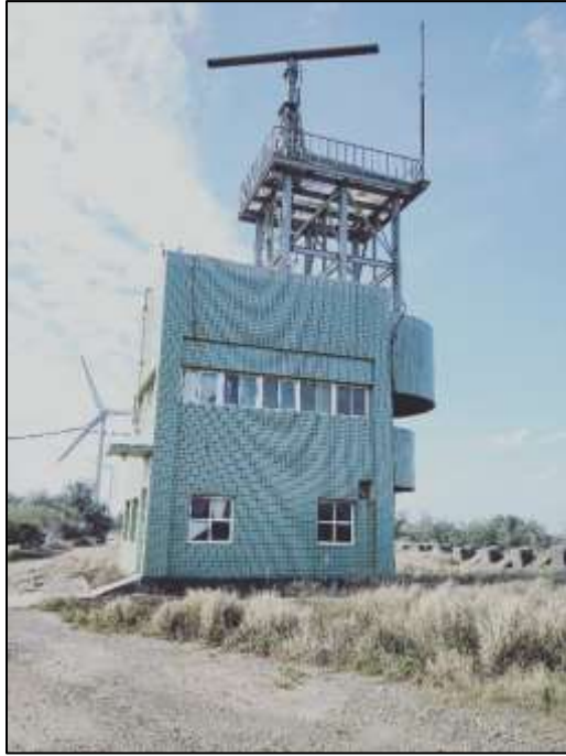
現況照片(桃園市觀音區大潭段小飯壠小段1126-1地號)
