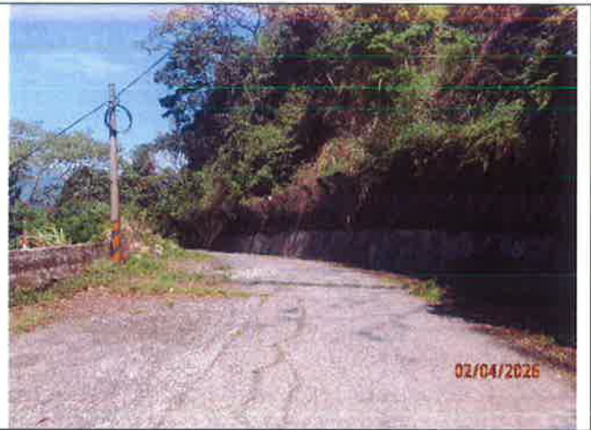
烏石坑林道巡視，X：244129 Y：2686237，截溝凹陷情形，車輛仍可通行。
