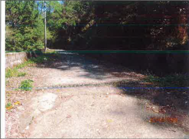
烏石坑林道巡視，X：244070，Y：2686202，截溝凹陷情形。
