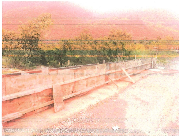
0K+60 林道護坡施工(未完工)
