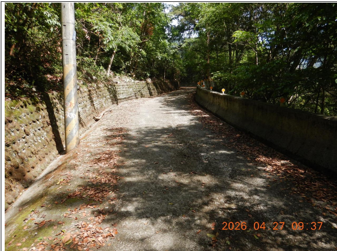
圖片3：0K+240，路面、邊溝、護欄，無異狀。
