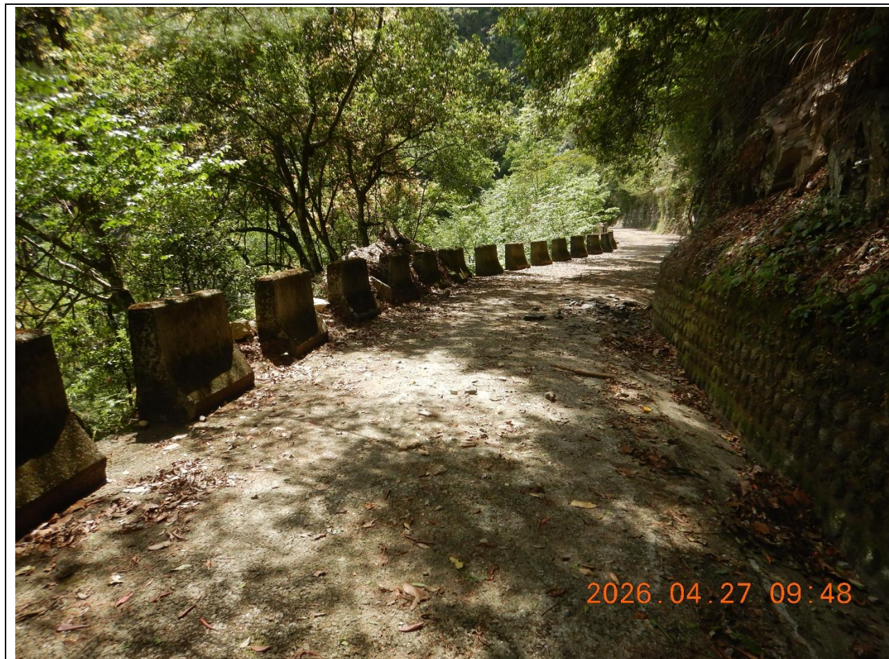
圖片5：0K+600，路面、邊溝、護欄，無異狀。
