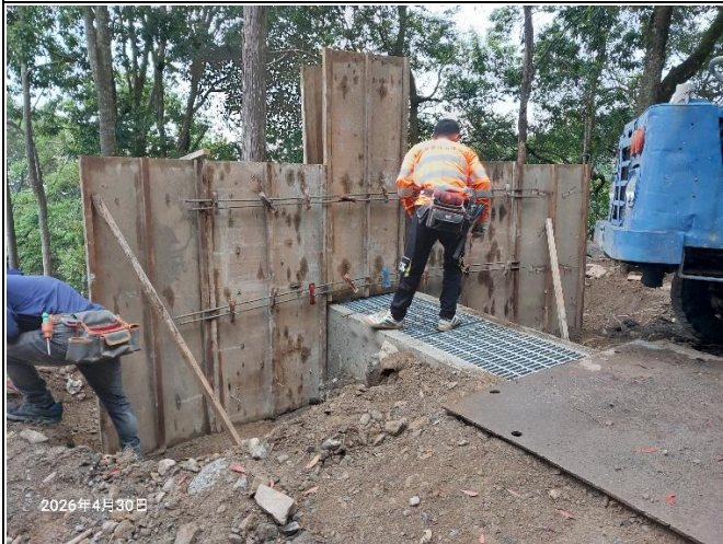
裡冷林道13K+400處，目前在進行路面灌漿、整地放鐵網，車輛無法通行。
