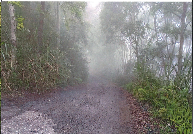
(4) 林道 6K+000k處約40公尺碎石級配路段因豪雨沖蝕左右邊分配不均車輛底盤會磨到。 座標：X：281244；Y：2599638。
