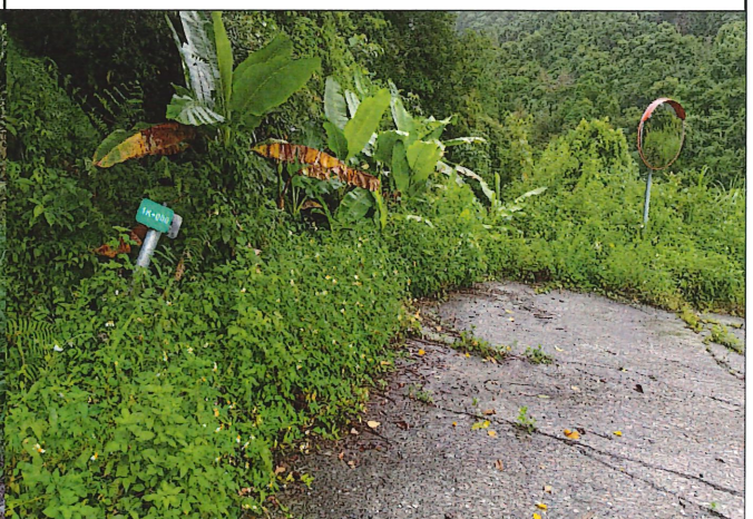
(6) 林道1k+000 處 里程標示牌有點歪歪的，其餘全線標誌均無受損 座標：X：282491；Y：2600807
