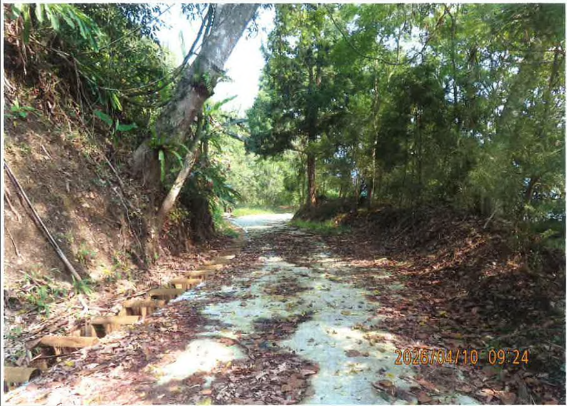
摩天嶺林道巡視良好。
