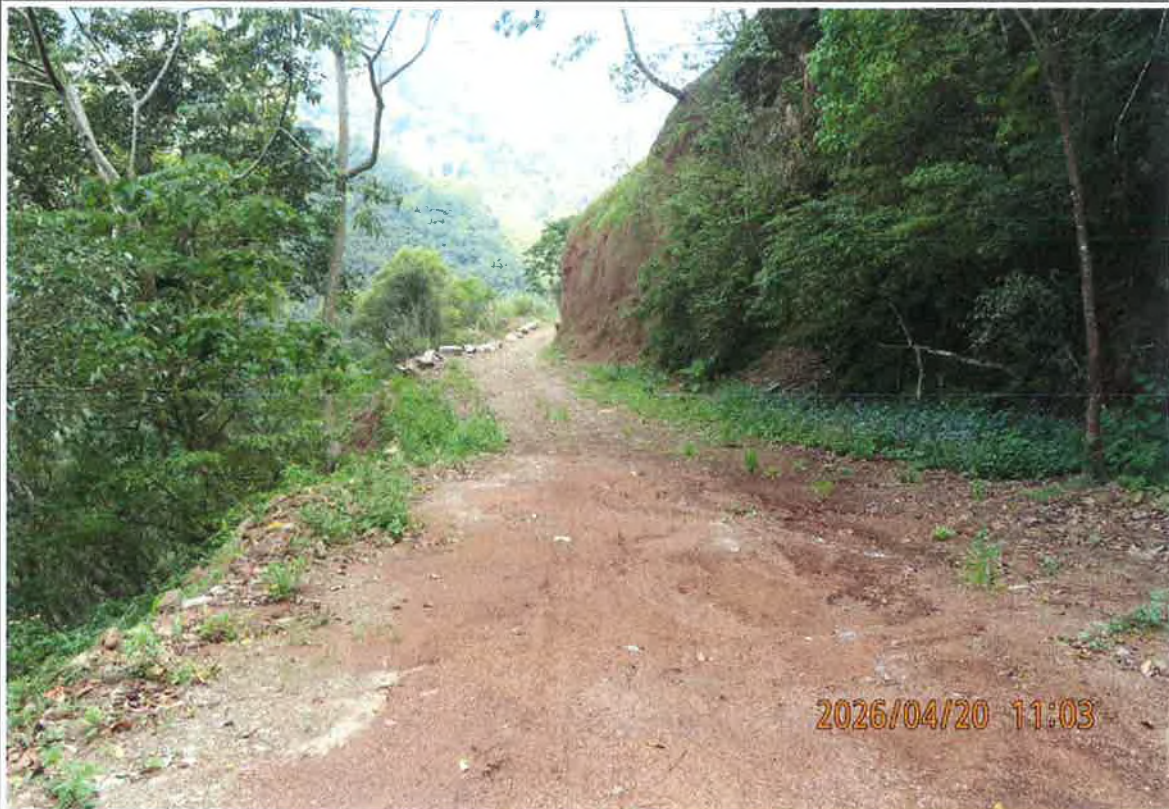
雪山坑林道巡視路面良好
