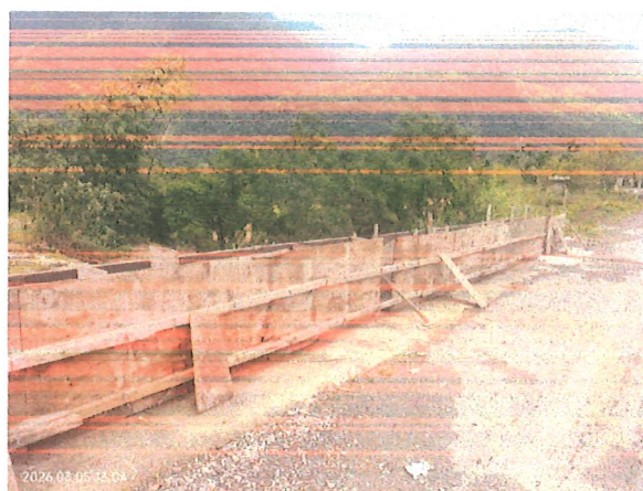
0K+60 林道護坡施工(未完工)
