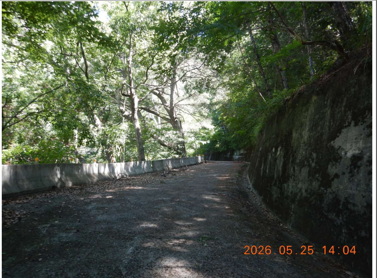
圖片2：OK+50，路面、邊溝、護欄，無異狀。
