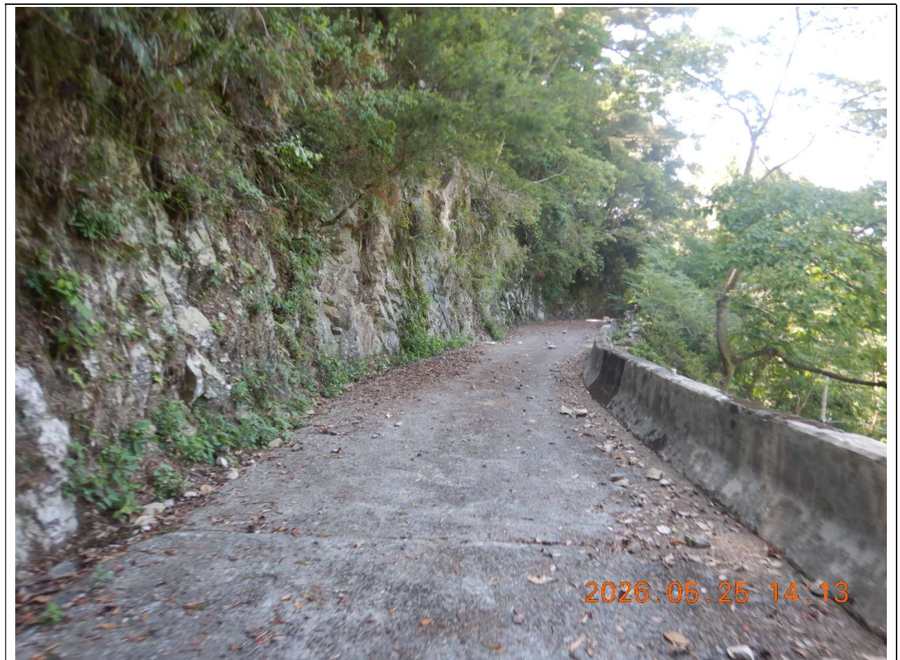
圖片5：0K+530，路面、邊溝、護欄，無異狀。
