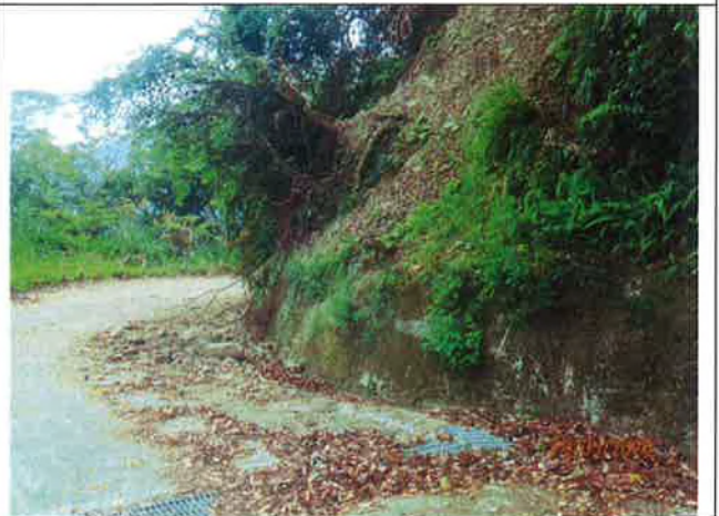
烏石坑林道巡視，X：244079，Y：2686325，坡面落石。
