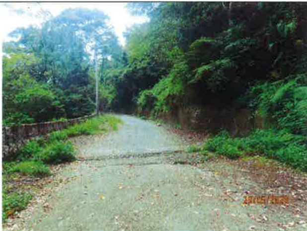
烏石坑林道巡視，X：244070，Y：2686202，截溝凹陷情形。
