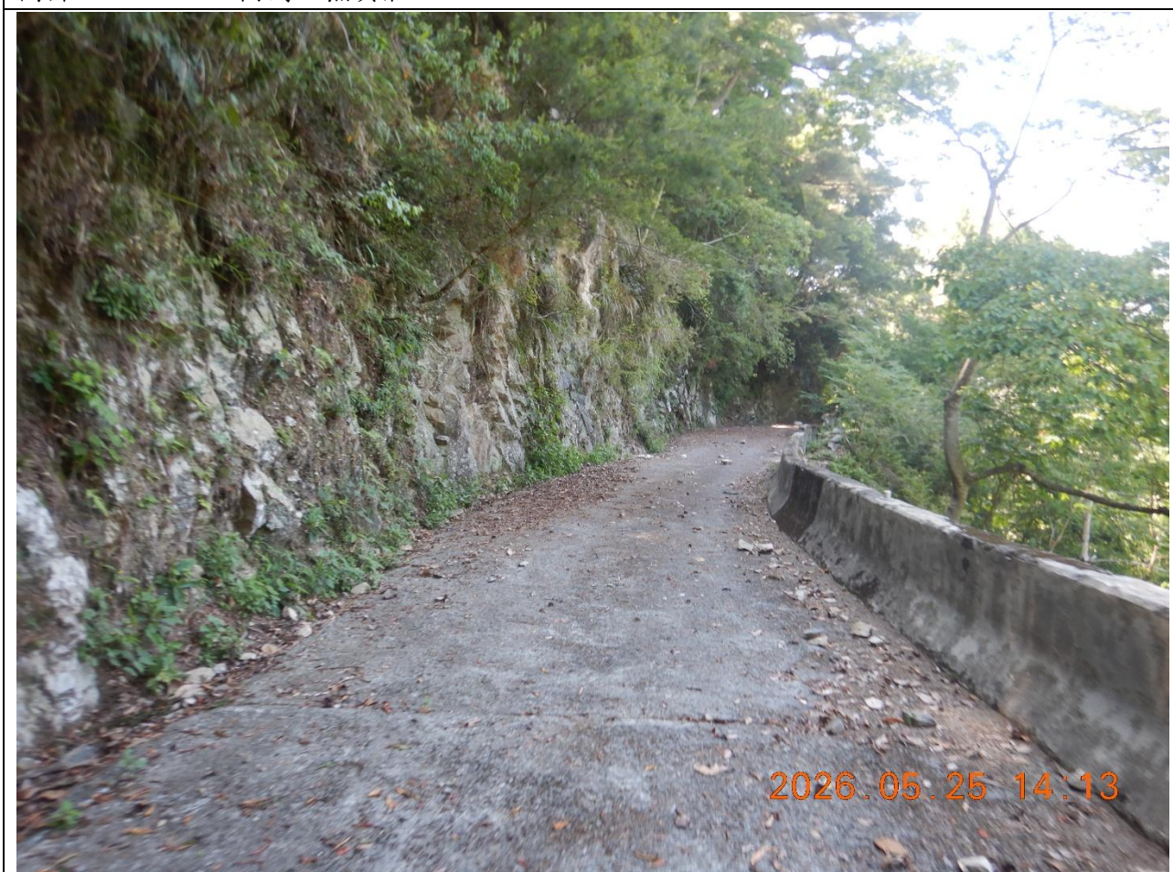
圖片5：0K+530，路面、邊溝、護欄，無異狀。
