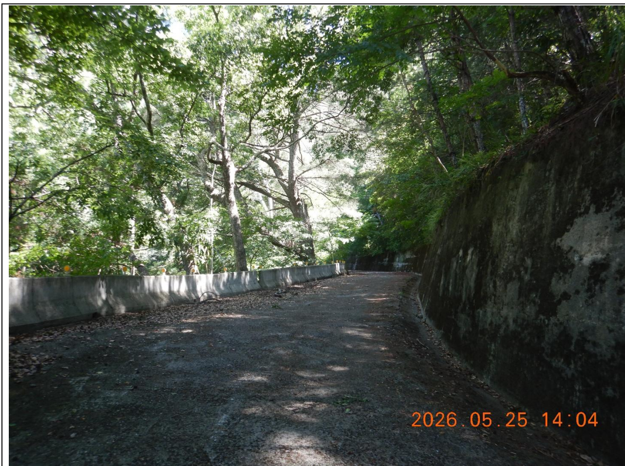
圖片2：0K+50，路面、邊溝、護欄，無異狀。
