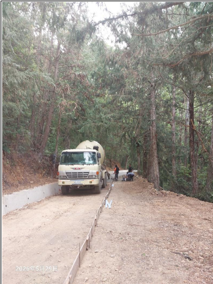
裡冷林道9K處，目前在進行路面灌漿、整地放鐵網，車輛無法通行。
